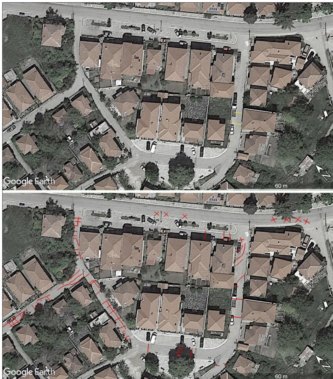
Εικόνα 3-6. Σύγκριση των χαρτογραφημένων ρωγμών του 2008 (επάνω) και του 2019 (κάτω). Νοτιότερο τμήμα του οικισμού
