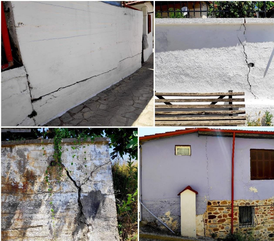
Εικόνα 1-1. Διάρρηξη σε τείχους και περιφράξεις οικιών της Στρατονίκης
