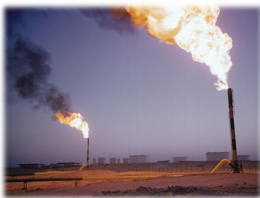
Εικόνα 1.2 : Μονάδα επεξεργασίας φυσικού αερίου 2
