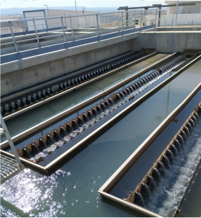
Εικόνα 14και 15: Φίλτρα διαχωρισμού νερού και κροκιδωμένων ουσιών και φίλτρα άμμου.
