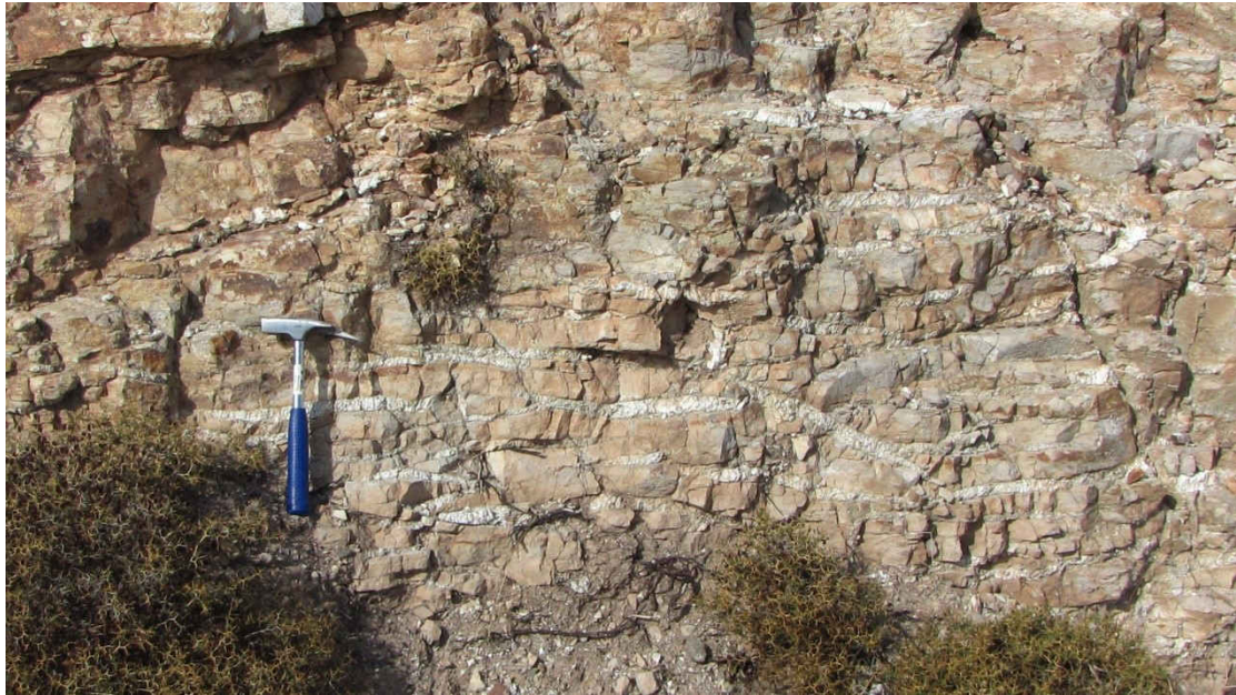
Φωτ. 81. Πτεροειδείς ρωγμώσεις αποτέλεσμα των διατμητικών τάσεων του εφελκυσμού μέσα στη ζώνη του ρήγματος
