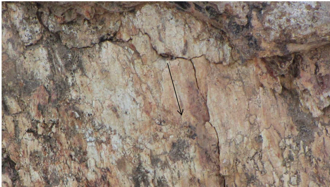
Φωτ. 80. Γράμμωση ολίσθησης αποτυπωμένη πάνω στην επιφάνεια ρήγματος
