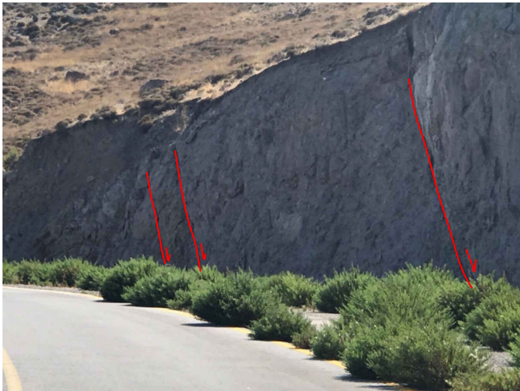
Φωτ. 7. Μεταπτωτικά ρήγματα με διεύθυνση ΒΔ-ΝΑ, κόβουν τα πυροκλαστικά υλικά του Σιγρίου.
