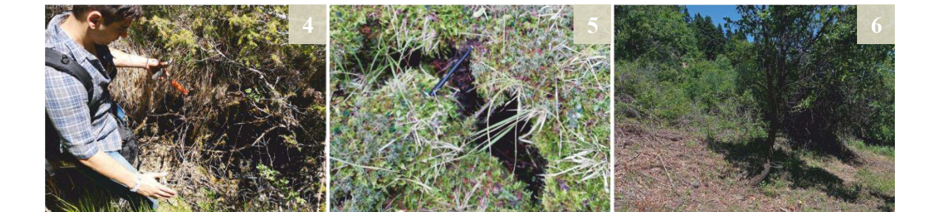
Εικόνα 5.22 Φωτογραφικό υλικό από την έρευνα στο πεδίο. 1, 6) Εμφανίσεις κορμών δέντρων με κοίλη καμπυλότητα προς τα ανάντη, χαρακτηριστικό σημάδι ερπυστικών κινήσεων (Sharpe, 1938). 3) Μετατοπισμένο τοίχο σκυροδέματος. 2) Εφελκυστικές ρωγμές επί του οδοστρώματος. Ο προσανατολισμός της ρωγμής είναι σχεδόν παράλληλος με την
