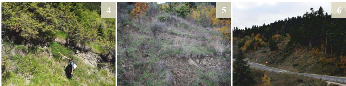
Εικόνα 5.20 Φωτογραφικό υλικό από την έρευνα στο πεδίο. 1) Δευτερεύουσα επιφάνεια κατακρήμισης της κύριας κατολίσθησης. 2 - 6) Κύριες επιφάνειες κατακρήμισης μικρότερων κατολισθήσεων εντός του ευρύτερου χώρου της κύριας κατολίσθησης.
