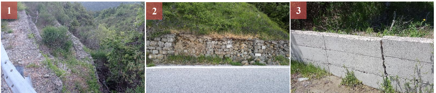
Εικόνα 7.6 Ενδεικτικές αστοχίες επί των ήδη υφιστάμενων έργων υποδομής. 1) Αστοχίες και παραμορφώσεις σε τεχνικό αντιστήριξης με σαρζανέτια, σε περιοχή ρέματος, εντός της κύριας κατολίσθησης, επί του παλαιού οδικού δικτύου Λαμίας – Καρπενησίου. 2) Αστοχίες συρματοκυβωτίων επί λιθόρριπτου τοίχου αντιστήριξης σε περιοχή εντός της κύριας κατολίσθησης, επί του παλαιού οδικού δικτύου Λαμίας – Καρπενησίου. 3) Μετατοπισμένα τοιχία σκυροδέματος σε περιοχή ανάντη του παλαιού δικτύου Λαμίας – Καρπενησίου, επί της τοπικής οδού, στα ανώτερα τμήματα της κύριας κατολίσθησης.
