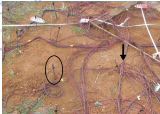
Σχήμα 5. 5. Ηλεκτρόδια και πολυκάναλα καλώδια.
