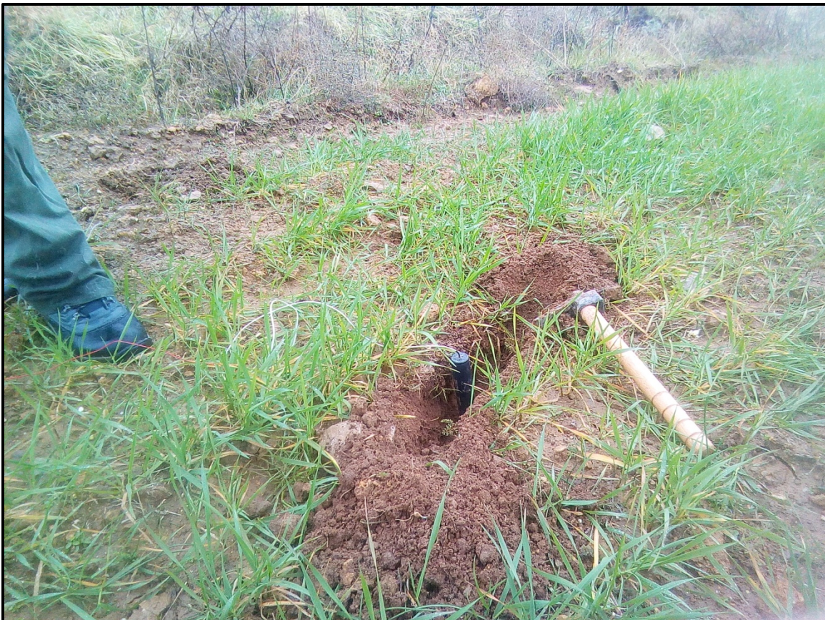
Εικόνα 3.1 Φωτογραφία από το θαμμένο σταθερό ηλεκτρόδιο βάσης. Δίπλα του το σφυρί που χρησιμοποιήθηκε για την εκσκαφή.
