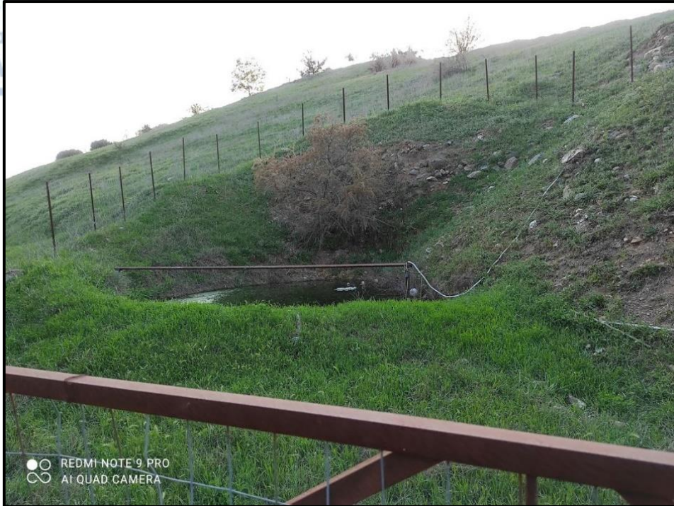
Σχήμα 6.5 Χώρος συγκέντρωσης και συλλογής στραγγισμάτων στο ΧΑΔΑ Θέρμης
