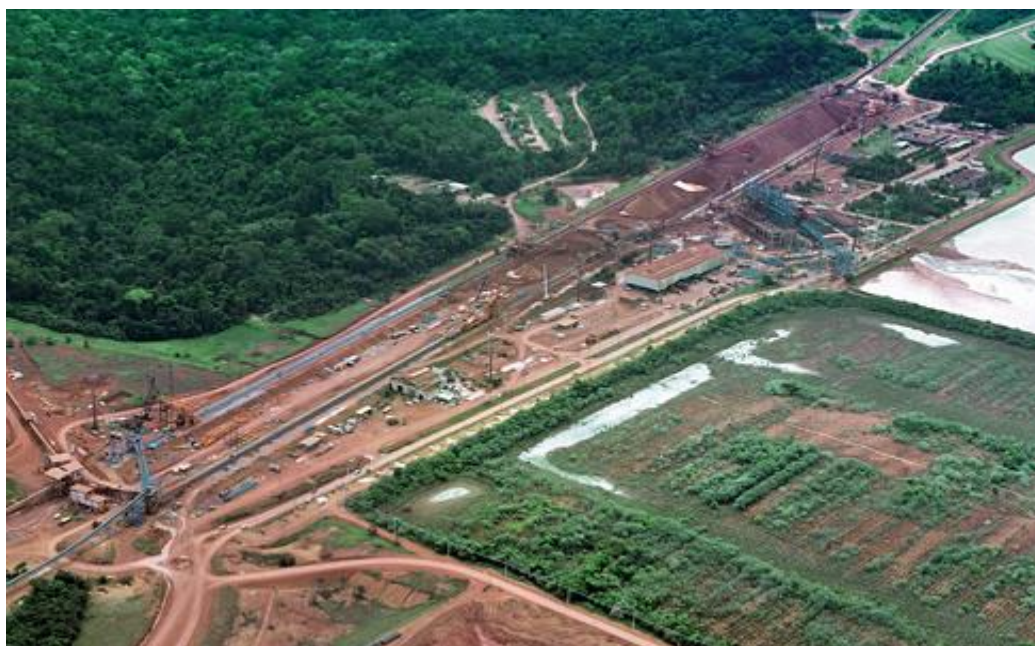
Εικόνα 7. Εγκαταστάσεις υπαίθριας εκμετάλλευσης βωξιτών, του κοιτάσματος Trobetas στη Βραζιλία (bauxite.world-aluminium.org)
