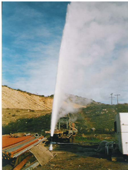
Εικόνα 27:Αρτεσιανή γεωθερμική γεώτρηση στον Ακροπόταμο Καβάλας (Fytikas et al., 2005)
