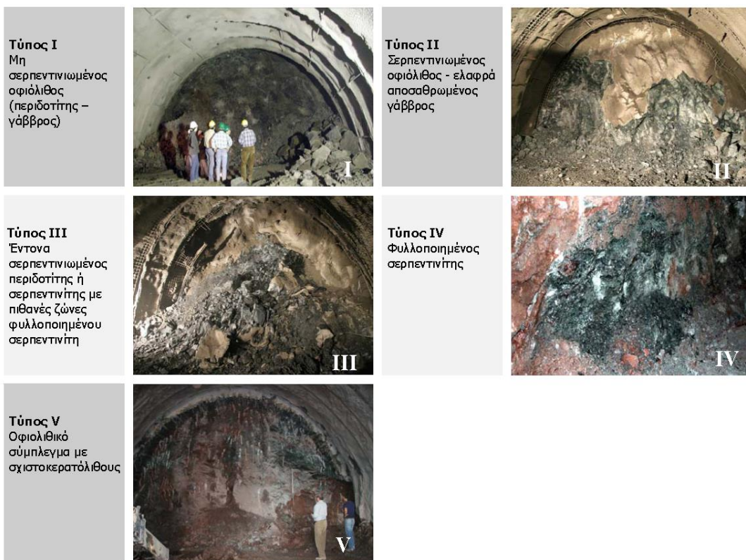
Εικόνα 35: Λιθότυποι βραχώμαζας των οφειολίθων με βάση τα τεχνικογεωλογικά χαρακτηριστικά. (Μαρίνος, 2007).
