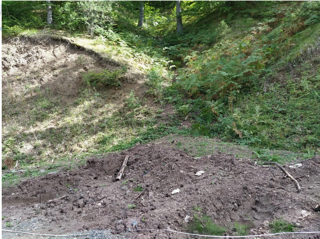
Εικόνα 53: Σημείο Απόθεσης 2. Φωτογραφία 8 μήνες μετά την εκδήλωση της λασπορροής.
