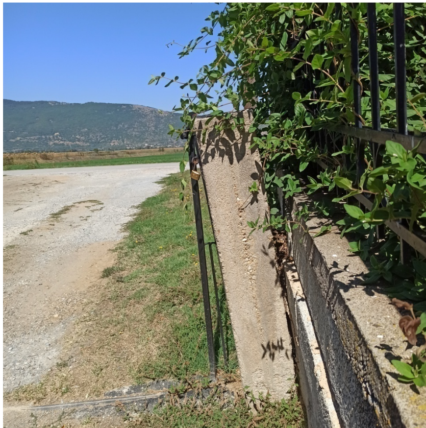
Φωτογραφία 8. Κλίση τοιχίου και εδάφους, Βαλτόνερα.
