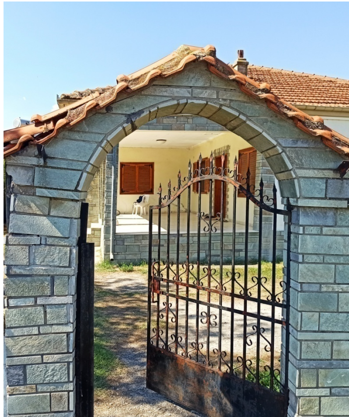
Φωτογραφία 1. Μετατόπιση σκέλους εξώπορτας στο χωριό Βαλτόνερα.
