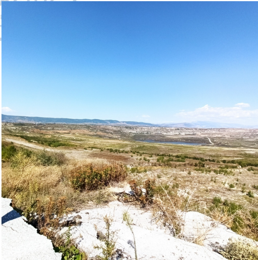
Φωτογραφία 15. Το ορυχείο των Αναργύρων μετά την κατολίσθηση.
