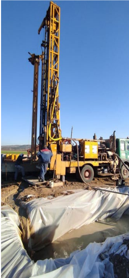
Σχήμα 7 Διάταξη γεωτρήπανου και πολφού συνεχούς ροής
