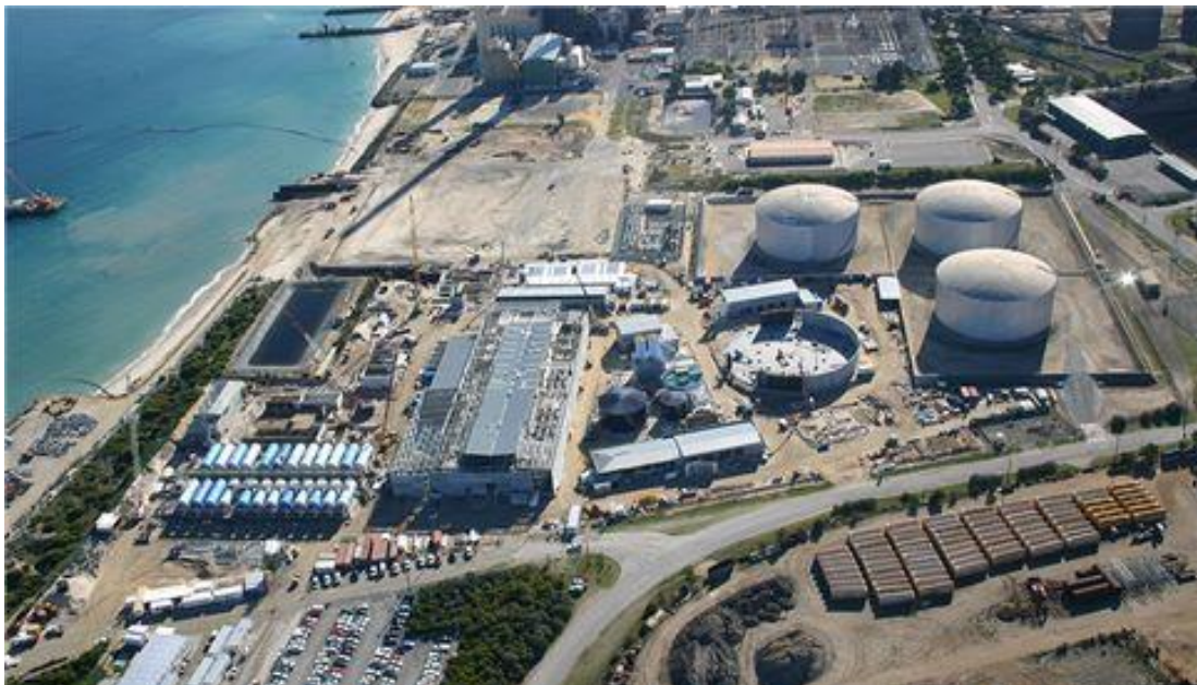
Εικόνα 35. Οι εγκαταστάσεις του εργοστασίου της μονάδας αφαλάτωσης στην περιοχή Kwinana στη Δυτική νότια Αυστραλία. (Πηγή: Safeguarding the Future of Perth's Drinking Water: Perth Seawater Desalination Plant. )
