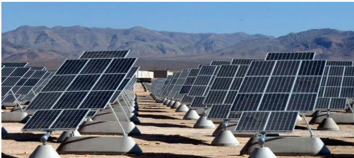
Εικόνα 16. Φωτοβολταϊκό πάρκο που φαίνονται τα πάνελ και ο μηχανισμός περιστροφή τους για τη μεγαλύτερη δυνατή παραγωγή ηλεκτρισμού. Πηγή: SIGMA HELLAS. https://www.sigmahellas.gr/el/energy/photovoltaic-pv/
