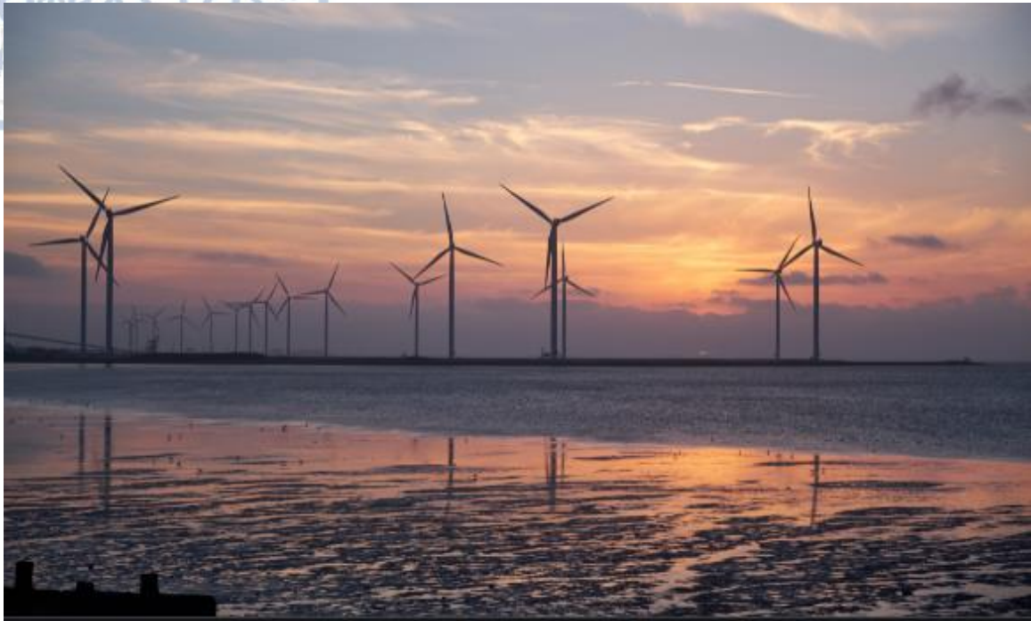
Εικόνα 18. Παράκτιο αιολικό πάρκο. (Πηγή: OFFLINE POST).
