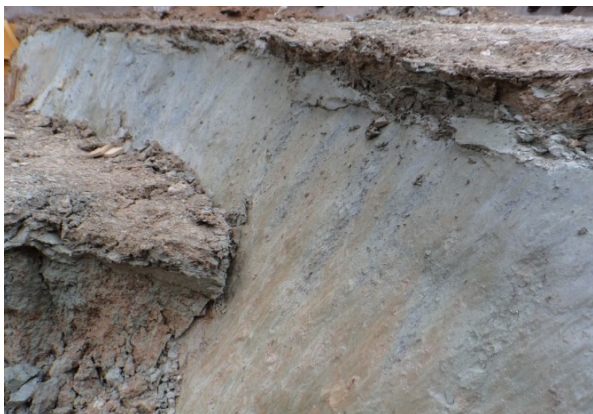
Επιφάνεια ολίσθησης μήκους 14 μέτρων σε εκσκαφή (βάθος 7 μέτρων από την επιφάνεια) σε αργιλικό στρώμα της ψαμμιτομαργαϊκής ενότητας.
