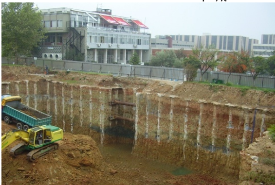
Εκσκαφή στην περιοχή του πανεπιστημίου για θεμελίωση του κτηρίου ΕΕ όπου φαίνονται οι ελαιοπράσινοι εμποτισμοί στα βαθύτερα στρώματα.
