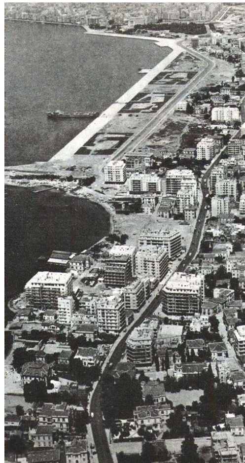
Σχ.15 Κατασκευή της επέκτασης της νέας παραλίας με επιχωματώσεις στις αρχές της δεκαετίας του 1960 (Δημόσια Ομάδα, Παλιές φωτογραφίες της Θεσσαλονίκης: https://www.facebook.com/groups/oldthessaloniki ).
