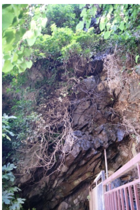
Παλιό λατομείο Ευαγγελίστριας. Υποεκσκαφή με μόνιμη ροή υδάτων.
