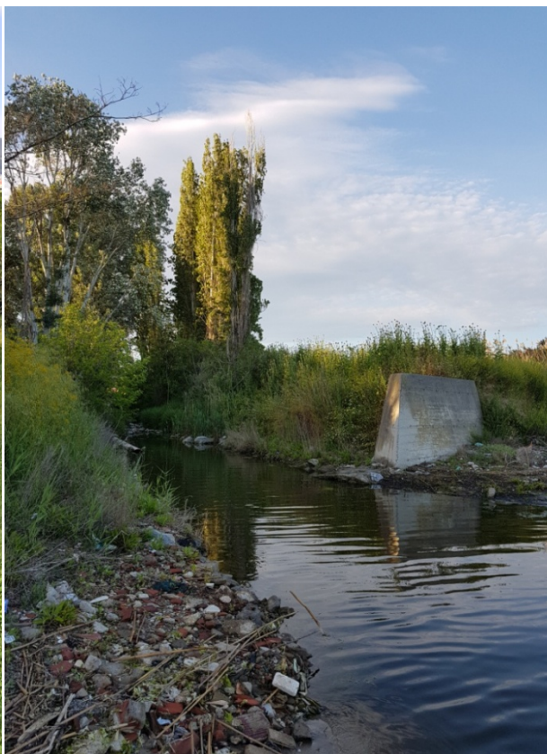
Σχ.78β Εκβολές της περιφερειακής τάφρου στον Θερμαϊκό Κόλπο στην Μίκρα.
