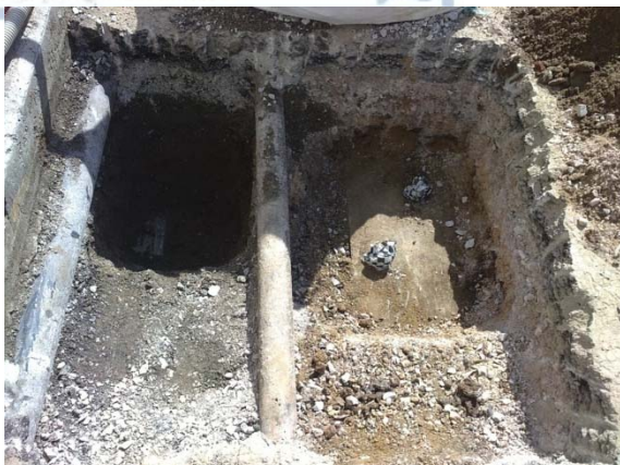
Σχ.4 Εξσκαφή όπου εντοπίστηκαν διάφορα δίκτυα Ο.Κ.Ω. σε πολλά διαφορετικά επίπεδα (Οδοφωτισμός, ΔΕΗ, ΕΥΑΘ).
