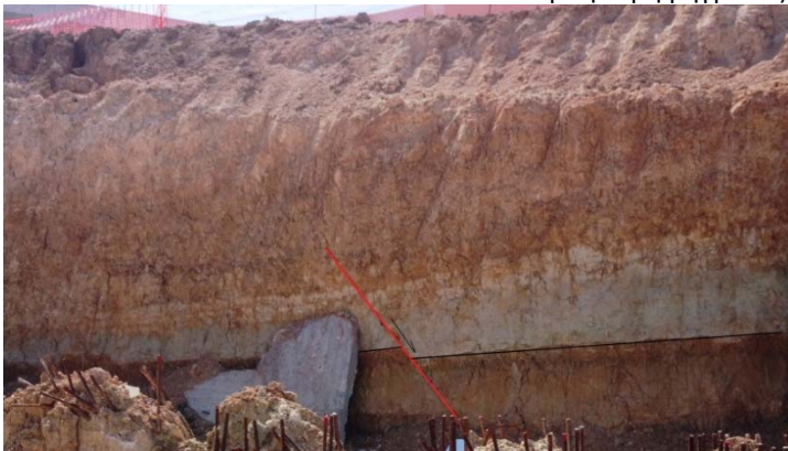
Μικροδιάρρηξη με μετατόπιση μέσα στην ψαμμιτομαργαϊκή ενότητα και λεπτομέρειά της όπου φαίνεται η μετατόπιση των στρωμάτων.
