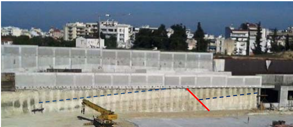
Σχ.114 Πανοραμική εικόνα εκσκαφής στην περιοχή Βότση όπου φαίνεται το κανονικό ρήγμα F-V1 με την μετατόπιση που παρουσιάζει (ametro.gr)
