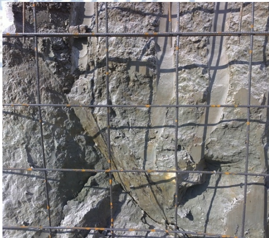
Σχ.34 Επιφάνειες ολίσθησης σε εκσκαφή, σε πρασινότεφρη και καστανότεφρη άργιλο αντίστοιχα.
