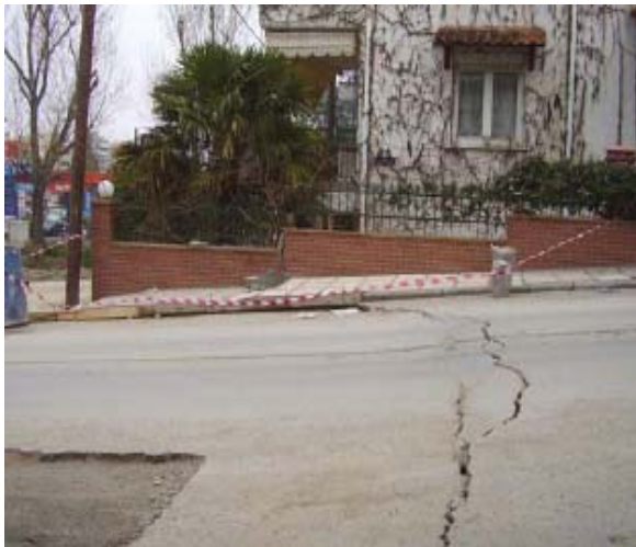
Επιφανειακή διάρρηξη το 2005 στην Περαιά (Θεσσαλονίκη) ύστερα από σεισμική ολίσθηση
