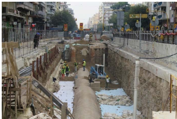
Σχ.5 Αγωγός αποχέτευσης κατά την εξσκαφή του σταθμού Αγ. Σοφίας του Μετρό Θεσσαλονίκης (ametro.gr).
