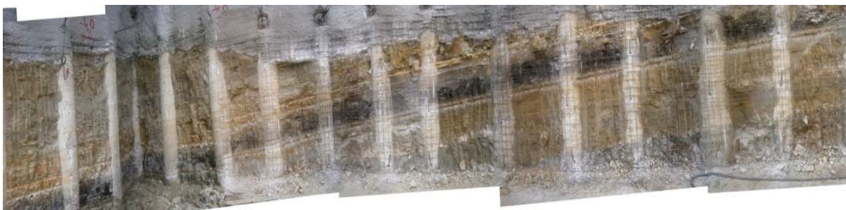
Σχ.32α Τομή εδάφους σε εκσκαφή όπου εντοπίζεται στρώση με οργανικά στοιχεία στον κατώτερο οριζοντα της ψαμμιτομαργακικής ενότητας. Περιοχή Βότση.
