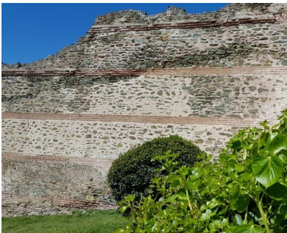
Τα βυζαντινά τείχη της Θεσσαλονίκης όπου χρησιμοποιούν ως δομικό υλικό τον πρασινοσχιστόλιθο Θεσσαλονίκης.
