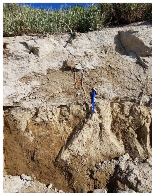
Σχ.110β Επιφάνεια ολίσθησης στο όριο των στρώσεων της ψαμμιτομαργαϊκής ενότητας.
