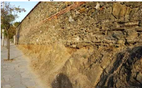
Θεμελίωση τοιχείου με πρασινοσχιστόλιθο πάνω από την επιφανειακή εκδήλωση του βραχώδους υποβάθρου (Οδ. Ε. Ζωγράφου).
