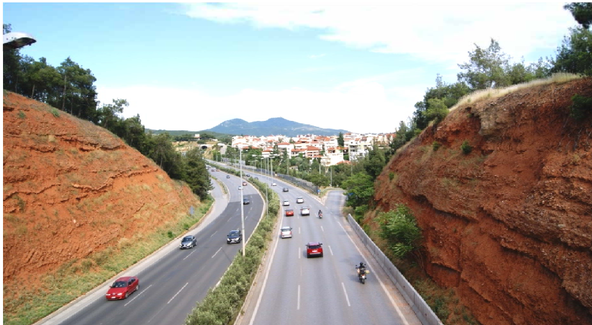
Σχ.37 Ορυγμα στην Περιφερειακή Οδό Θεσσαλονίκης, όπου φαίνεται οι εναλλαγές των στρώσεων μεταξύ στιφρής αμμώδους αργίλου, λατυποπαγών και χαλικωδών οριζόντων. Εντυπωσιακό είναι το ύψος των κατακόρυφων πρανών χωρίς ανάγκη αντιστήριξης.
