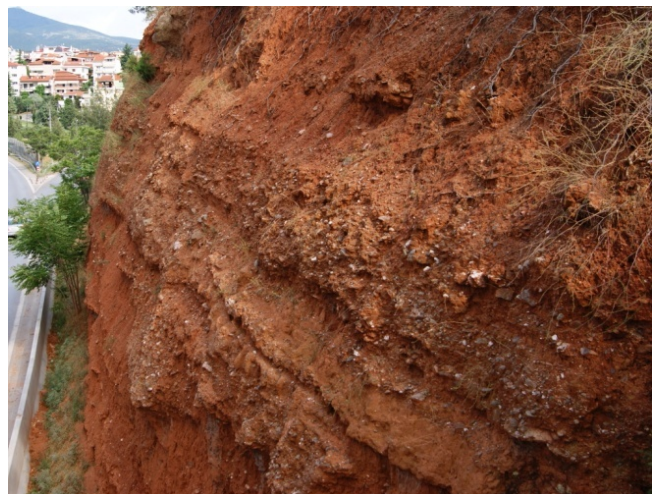
Λεπτομέρεια εκσκαφής στον σχηματισμό Ερυθρών Αργίλων (Περιφερειακή οδός) όπου διακρίνονται οι εναλλαγές οριζόντων.
