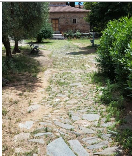
Διάστρωση τοπικής οδού με πρασινοσχιστόλιθο (Βυζαντινή εκκλησία Άνω Πόλης, Αγ. Νικόλαος Ορφανός)
