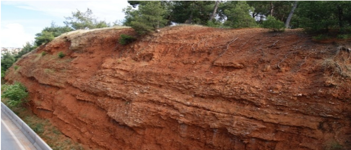
Τομή εκσκαφής στον σχηματισμό Ερυθρών Αργίλων στην Περιφερειακή οδό Θεσσαλονίκης. Διακρίνονται οι εναλλαγές χαλικιών και αργιλωδων οριζόντων.
