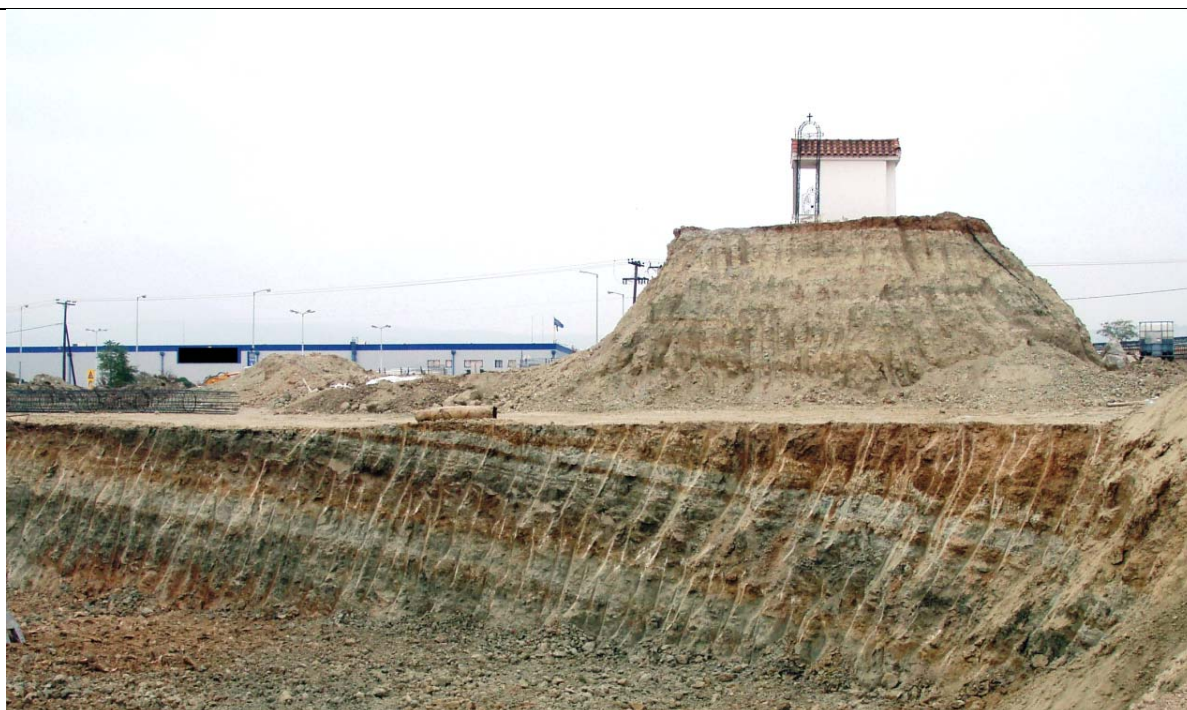
Τομή εκσκαφής στην περιοχή Βότση όπου φαίνονται οι στρώσεις υπό κλίση της ψαμμιτομαργαϊκής ενότητας.
