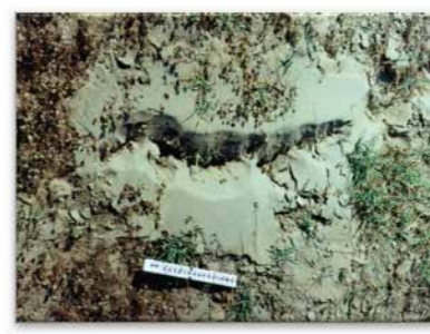
Φαινόμενο ρευστοποίησης του εδάφους κατά μήκος των σεισμικών ρωγμών στο ρήγμα του Στίβου κατά τον Σεισμού του 1978 (Φωτ. Γ. Συρίδης)
