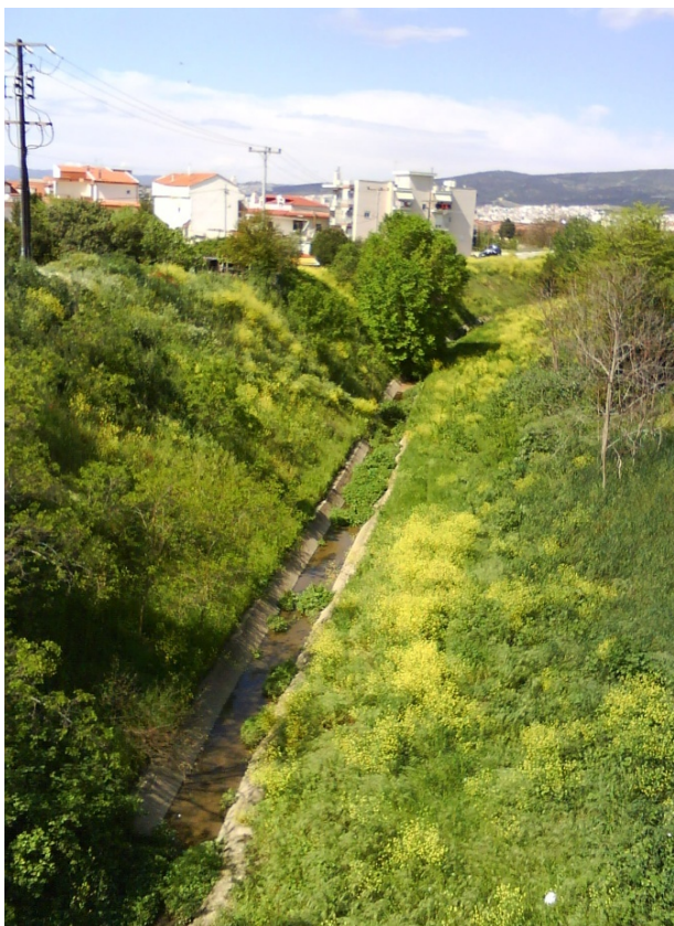
Σχ.78α Περιφερειακή τάφρος στην περιοχή του Φοίνικα.
