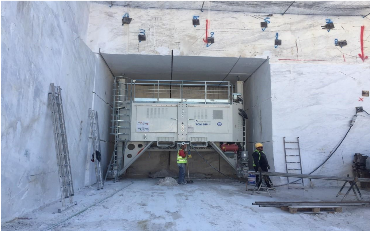
Σχ. 48. Διάνοιξη θαλάμου για την έναρξη της υπόγειας εξόρυξης (Ικτίνος Ελλάς Α.Ε.).
