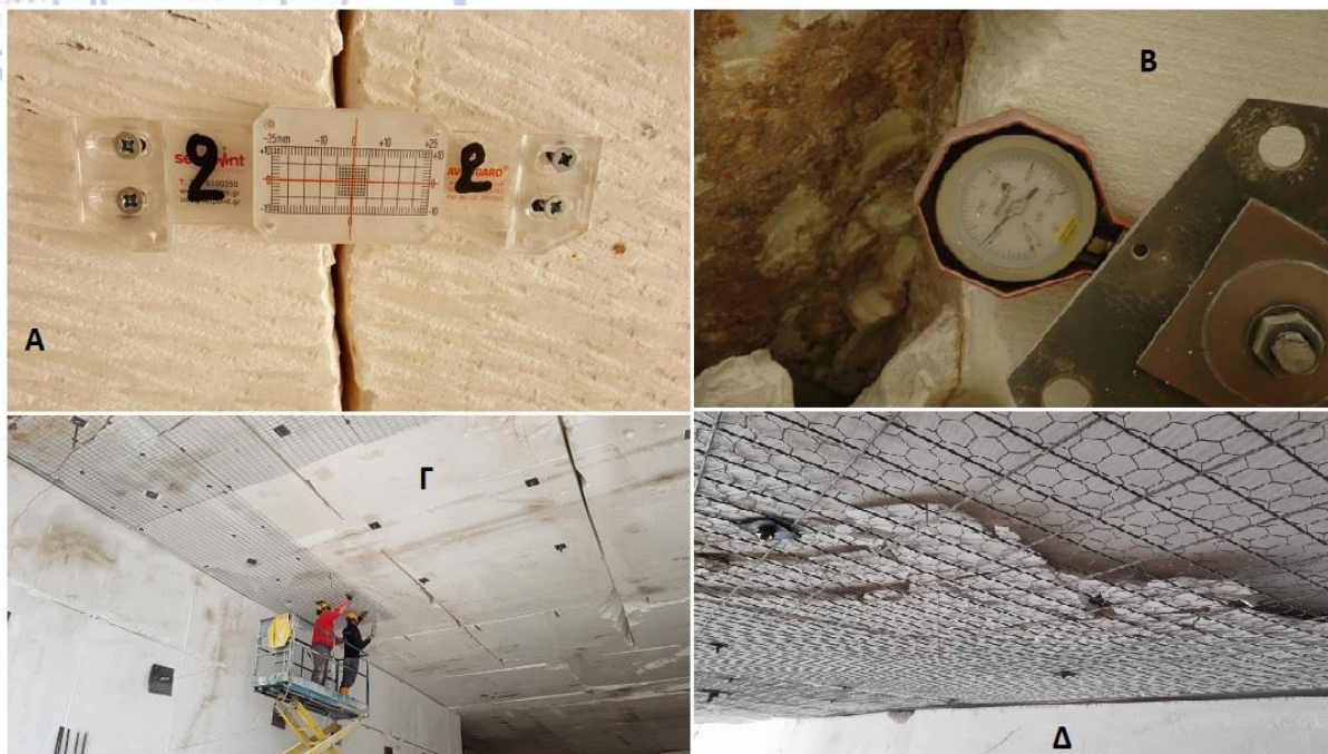
Σχ. 49. Όργανα παρακολούθησης και μέτρα ασφαλείας σε υπόγεια εκμετάλλευση (oryktosploutos.net).
