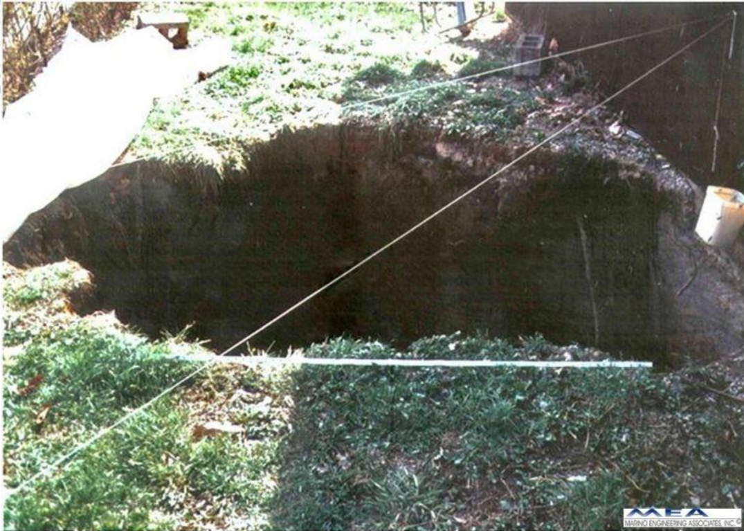
Σχ. 7. Καταβόθρα που δημιουργήθηκε από καθίζηση σε μεταλλείο μεταλλεύματος (Marino Engineering Associates 2020).
