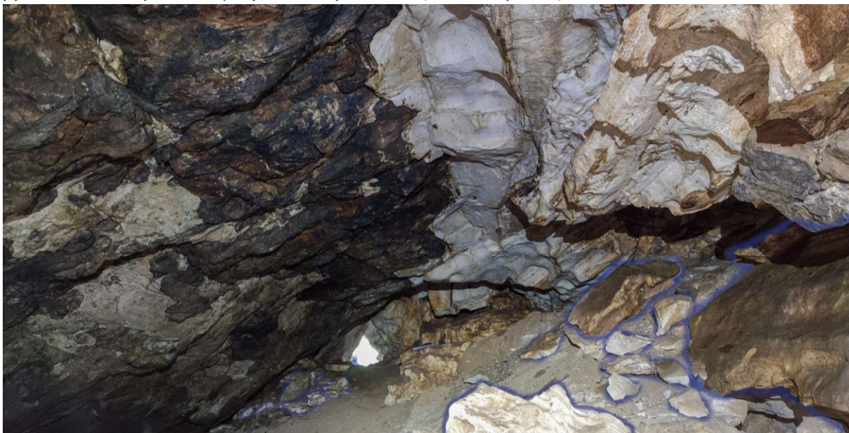
Εικόνα 26. Παρατήρηση των ογκολίθων από κατάπτωση τεμάχων της οροφής οι οποίοι παρουσιάζονται σκιαγραφημένοι με μπλε χρώμα. Εμφανείς είναι οι αρχικές θέσεις των επικολληθέντων τεμαχών από κοιλότητες στην οροφή (Φωτ. Καράμπελας Α. ).
