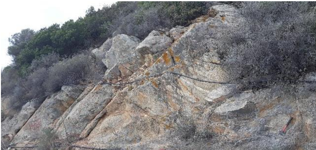
Εικόνα 24. Παραμόρφωση πάνω στο γρανίτη και αποκολλήσεις του πετρώματος. ΝΑ-ΒΔ προσανατολισμός φωτογραφίας.
