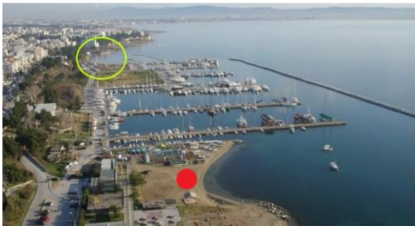
Εικόνα 3.39 Απεικονίζεται η περιοχή της Αρετσούς όπως είναι σήμερα (2023), όπου διακρίνονται οι πολύ έντονες μεταβολές που έχει υποστεί η ακτογραμμή της περιοχής με τις επιχώσεις πολλών μέτρων, που έλαβαν χώρα, για την κατασκευή των εγκαταστάσεων της μαρίνας. Ακόμα, επισημαίνεται με τον κίτρινο κύκλο το σημείο, όπου έχει παρατηρηθεί έντονη διάβρωση από τη μία πλευρά της μαρίνας, ενώ με τον κόκκινο κύκλο τονίζεται η συσσώρευση ιζήματος από την άλλη πλευρά της μαρίνας.
