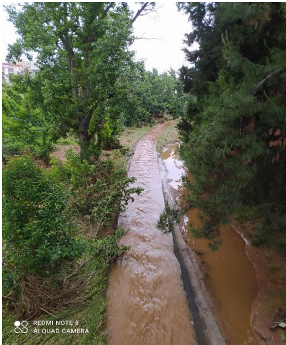
Εικόνα 3.58 Φωτογραφία της περιφερειακής τάφρου ένα 24ωρο μετά από πολύ έντονη βροχόπτωση (φωτο στις 17/6/2023 από τη γέφυρα όριο Πυλαίας-Θεσσαλονίκης, οδοί Προφ. Ηλία-Πλαστήρα).
