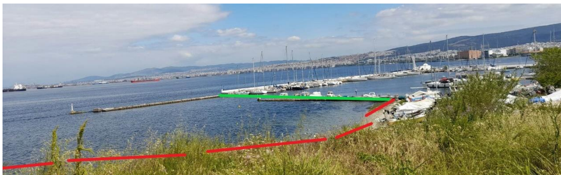
Εικόνα 3.14 Απεικονίζεται η μαρίνα Ν.Ο.Θ. Η ακτογραμμή οριοθετείται με κόκκινη γραμμή. Με πράσινη γραμμή επισημαίνεται η επίχωση των λιμενοβραχίονα της μαρίνας μέσα στη θάλασσα.
