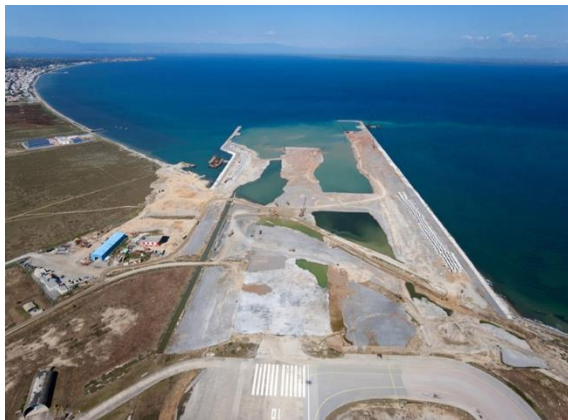
Εικόνες 3.74, 3.75 Αεροφωτογραφίες από την επέκταση του αεροδιαδρόμου του αερολιμένα της Θεσσαλονίκης μέσα στη θάλασσα που προσεγγίζει τα 998,277 μέτρα.
