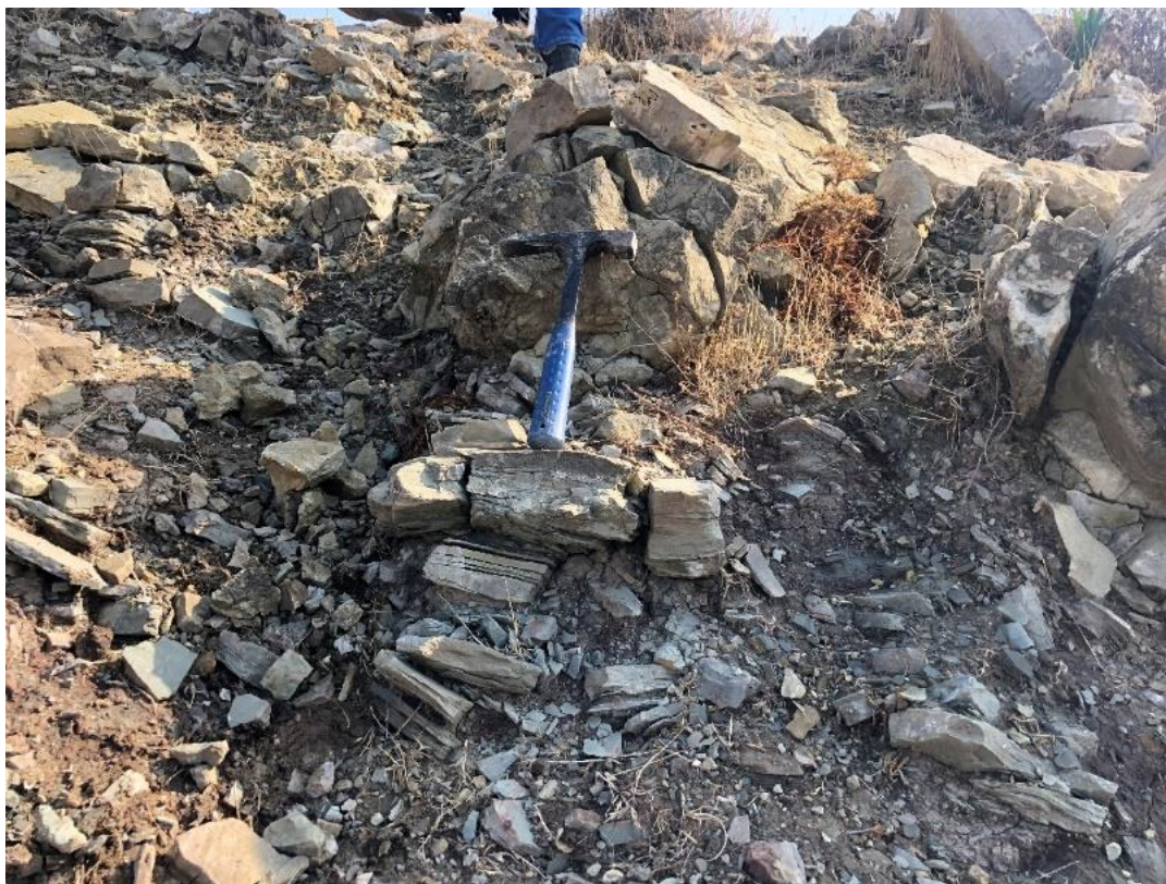
Σχήμα 3.13. Ασβεστολιθικά στρώματα του Σχηματισμού Μαρώνας, όπως αυτά αναγνωρίζονται στο αριστερό πρηνές του φράγματος Μαυροκόλυμπος.
