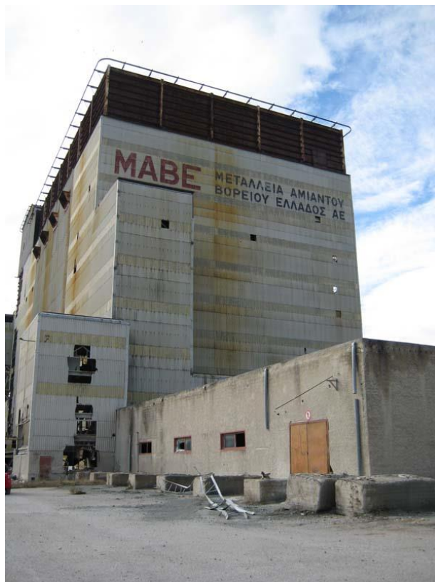
Σχήμα 19 Εργοστάσιο Επεξεργασίας των MABE στο Ζιδάνι της Κοζάνης
