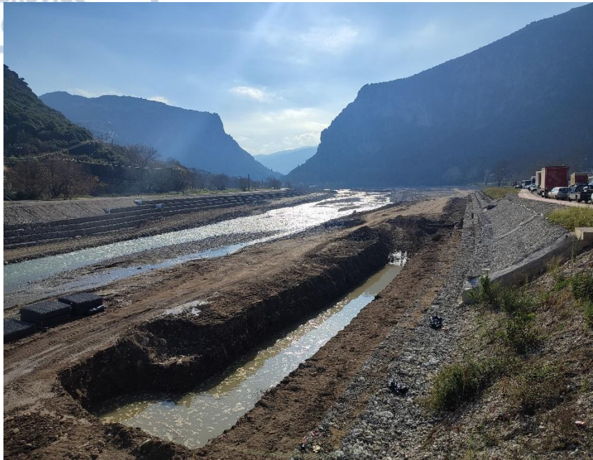
Σχήμα 61. Έργα αποκατάστασης της καταστροφής στην κοίτη του ποταμού Πάμισου στο Μουζάκι το Δεκέμβριο του 2023. Στο βάθος φαίνονται τα στενά του Κόζιακα.
