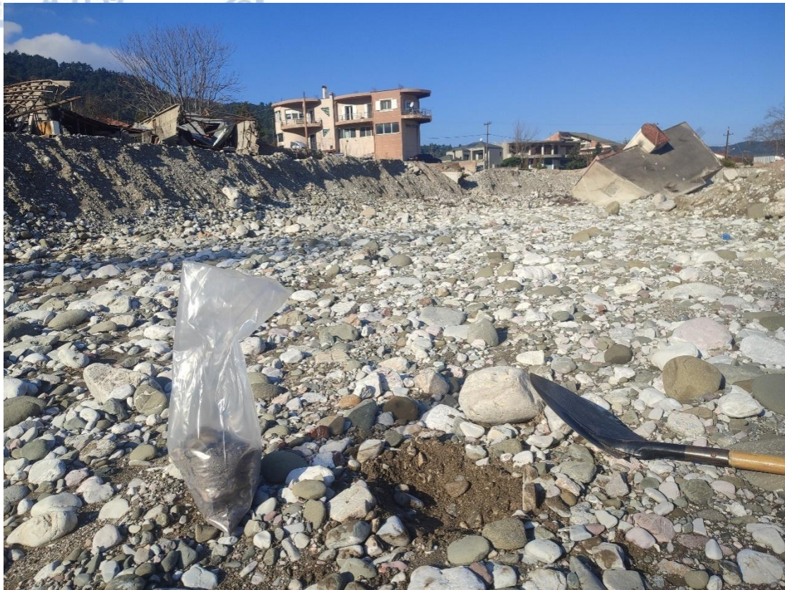
Σχήμα 38. Ακριβές σημείο δειγματοληψίας του δείγματος PAM01, εντός της κοίτης του Πάμισου. Διακρίνονται τα διάφορα μεγέθη του υλικού που έχει αποτεθεί. Στο βάθος διακρίνεται το κτίριο που έχει καταρρεύσει
