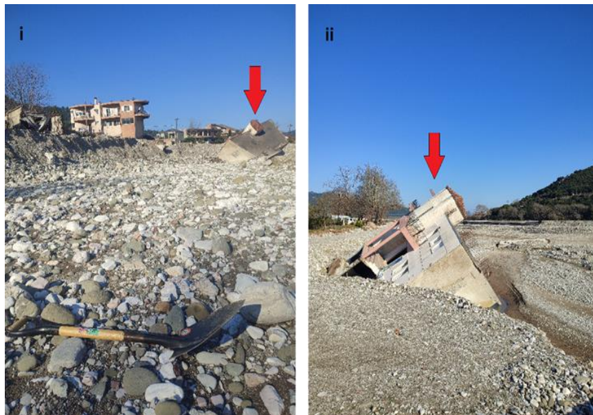
Σχήμα 60. Το πεσμένο κτίριο στην κοίτη του ποταμού. i) Φωτογραφία μέσα από την κοίτη του ποταμού. ii) Φωτογραφία πάνω από την κοίτη του ποταμού. Με κόκκινο βέλος υποδεικνύεται το κτίριο που έχει καταρρεύσει.
