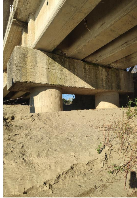
Σχήμα 47. Φωτογραφίες από τη Θ5 εντός της κοίτης του Πάμισου. i) Ακριβές σημείο δειγματοληψίας του PAM05. ii) Οι βάσεις της γέφυρας που έχουν σχεδόν σκεπαστεί από το λεπτόκοκκο αμμιώδες υλικό που έχει αποτεθεί.
