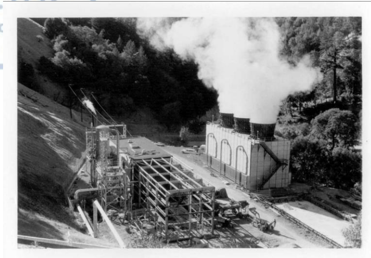
Εικόνα 8: Η πρώτη γεωθερμική ηλεκτροπαραγωγική μονάδα της PG&E, 1960 (πηγή: www.geysers.com )
