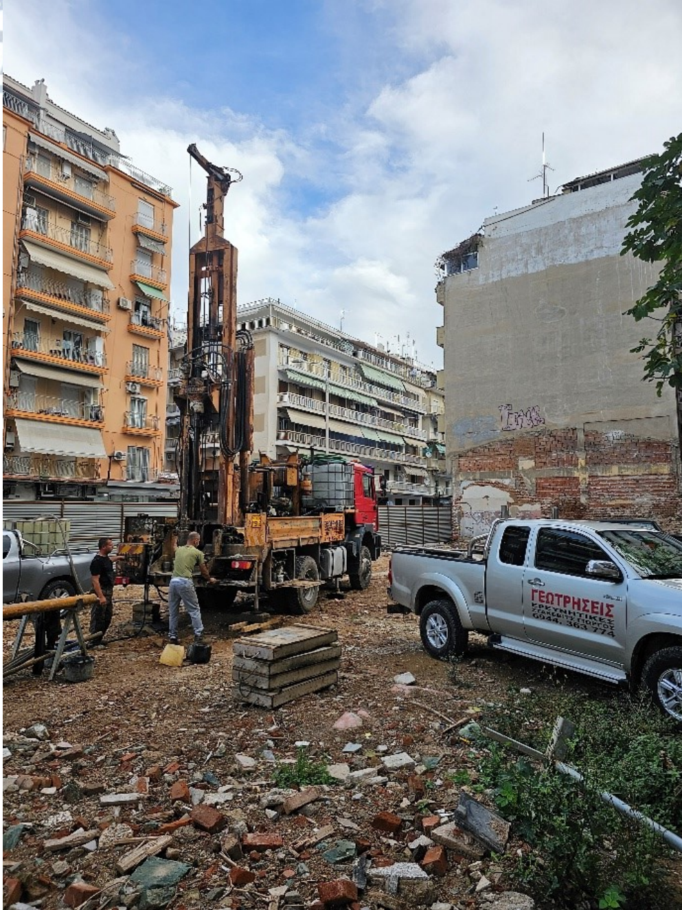
Εικόνα 13. Εκτέλεση γεώτρησης στη θέση Γ2
