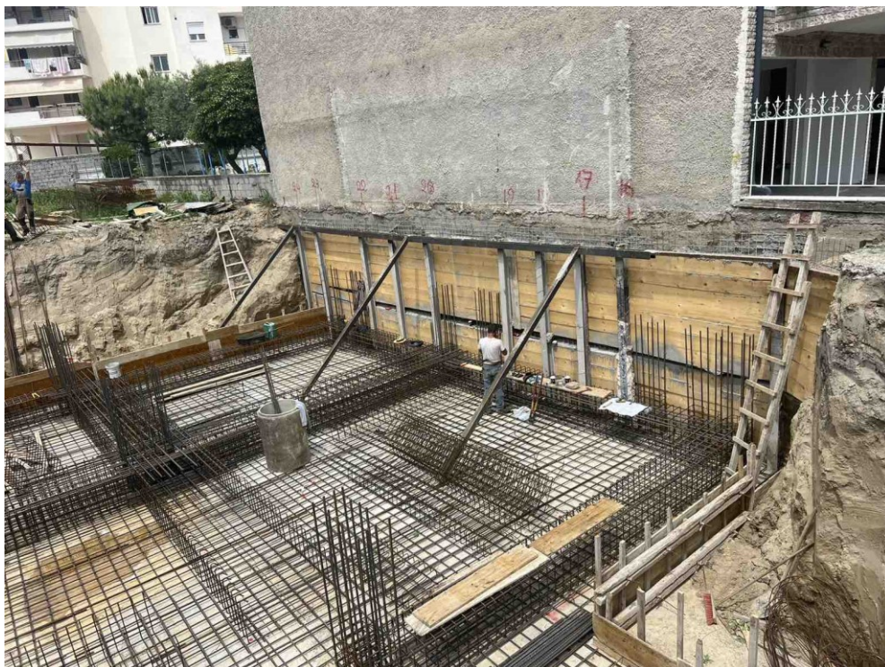
Εικόνα 30. «Τοίχος Βερολίνου» με σανίδες και αντηρίδες σε εφαρμογή
