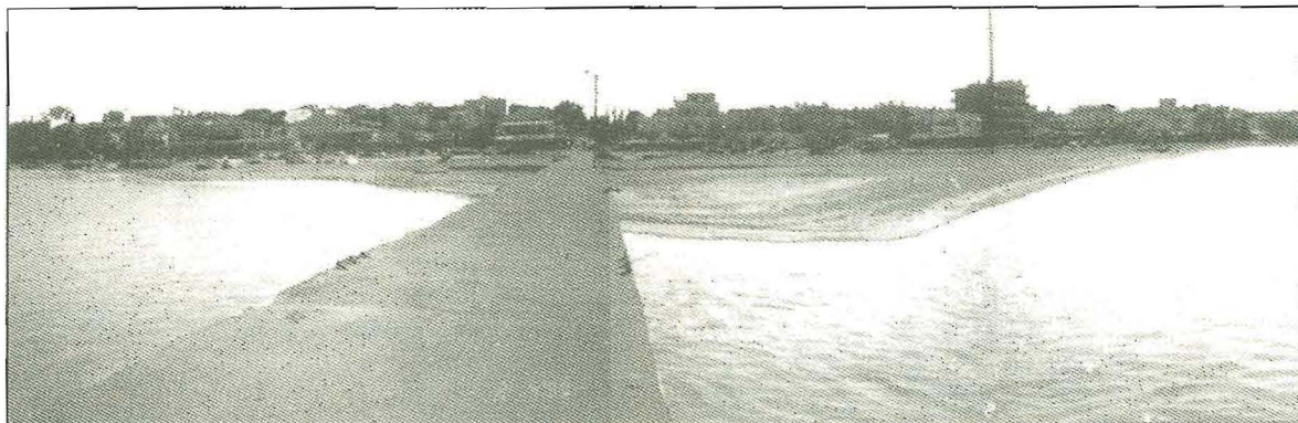
Φωτ 1.: Απόθεση άμμου στην κυματική σκιά του κυματοθραύστη στους Νέους Επιβάτες, συνολικής επιφάνειας 11.000 m 2 .
