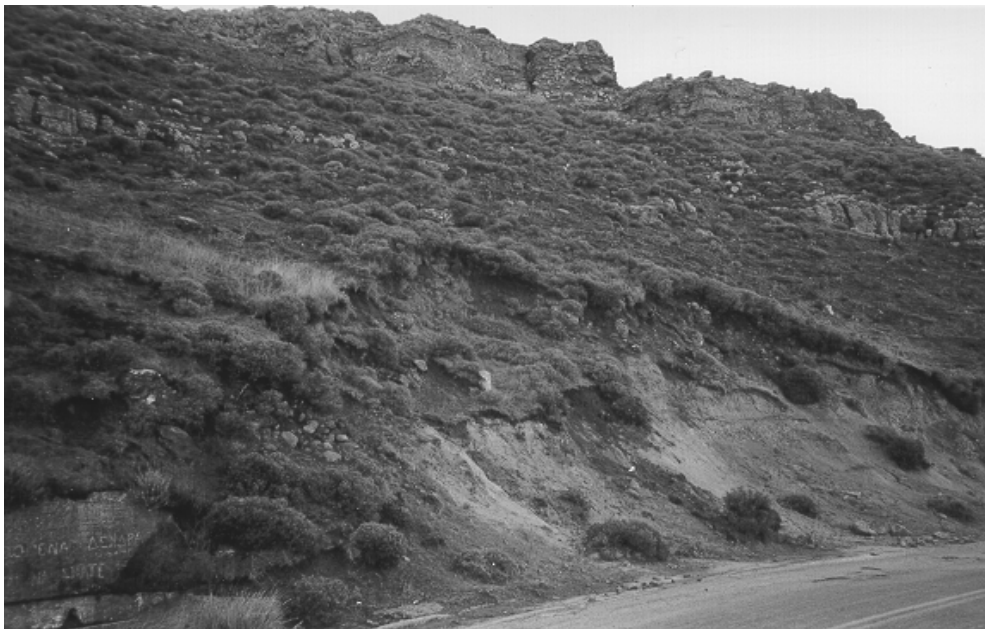
Σχ.4: Στη φωτογραφία διακρίνεται περιστροφική ολίσθηση. Fig.4: In the photo a slump is distinguished.
