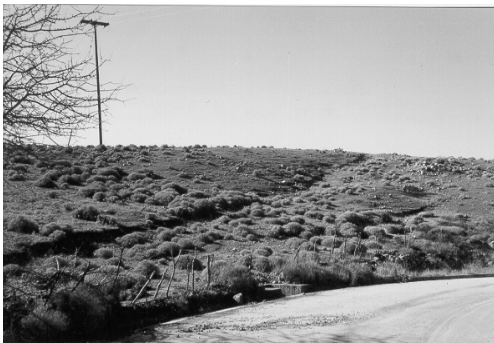
Σχ.5: Διακρίνεται ρωγμώδης ασυνέχεια στην επιφάνεια της κλιτύος εξ αιτίας ερπυσμού και πλεγματοειδείς ρωγμές στον ασφαλτοτάπητα. Fig.5: A fracture showing the creeping.
