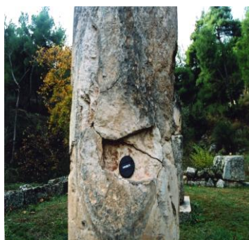
Σχήμα 4. Μαργαίος ασβεστόλιθος σε κίονα του ναού με έντονα ρηγματωμένη επιφάνεια.
