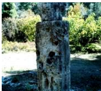
Σχήμα 5. Κίονας της στοάς από ασβεστοψαμμίτη που παρουσιάζει έντονη γήρανση.
