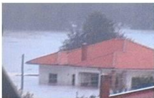
Μελισσουργός στάθμη νερού στον όροφο
