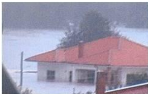
Μελισσουργός στάθμη νερού στον όροφο
