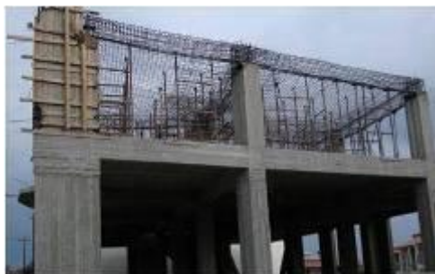
Πολύχρονο κατοικία υπό ανέγερση
